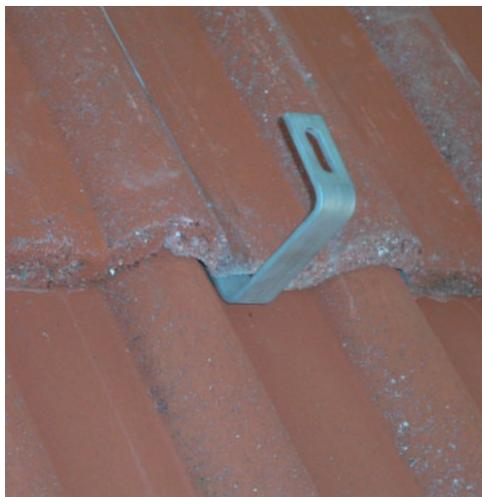
Je nach Form der Dachziegel ist ggfs. ein Abschleifen notwendig (Flex mit kleiner Diamantscheibe verwenden!), damit die Ziegel samt Dachhaken wieder schließen.
