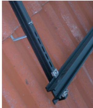
Bei dieser Befestigungsweise müssen die Dachhaken entsprechend den Kollektorrahmen und den Dachsparren montiert werden.
