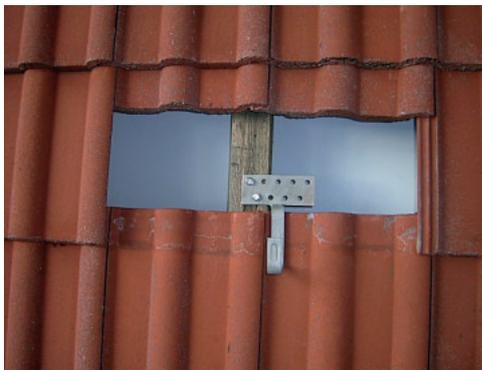
Der senkrechte Abstand der Dachhaken wird durch die Befestigungslöcher im Längsrahmen vorgegeben.
